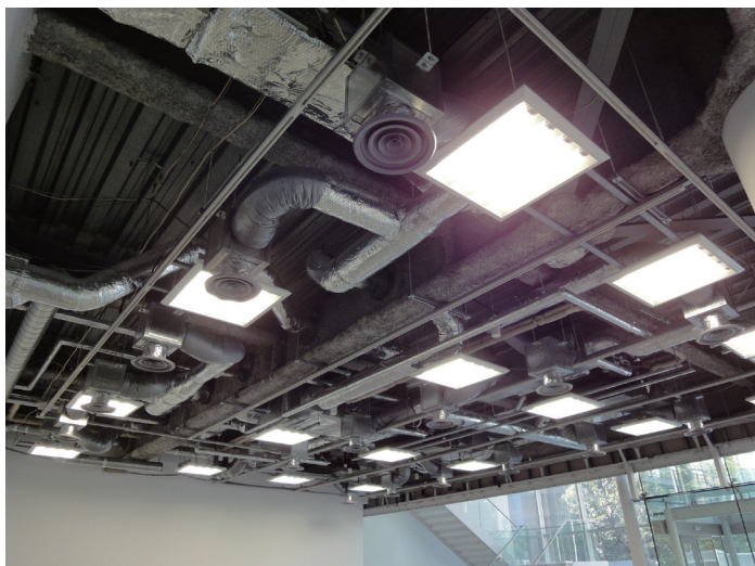
ホール付近 既存天井
